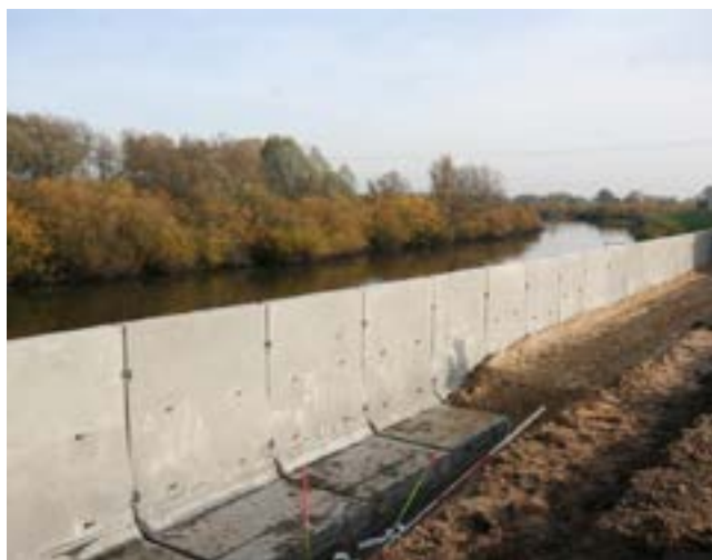
Aplicación en muros de contención
