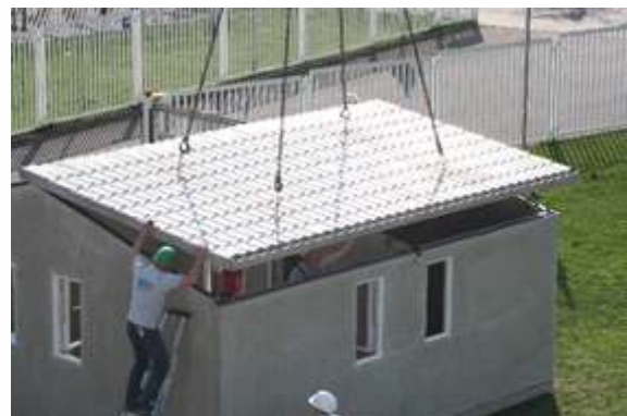
6. Montaje del techo de dos aguas
