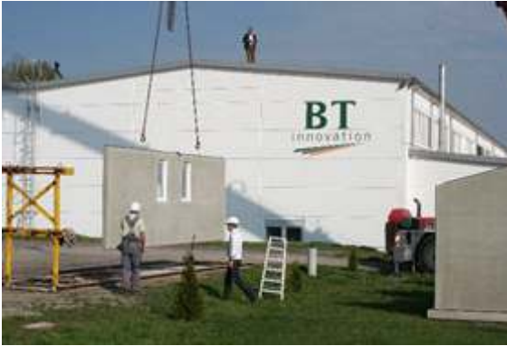
1. Construcción con ayuda de una grúa
