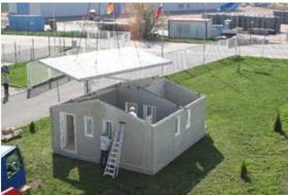
5. Construcción del techo de dos aguas
