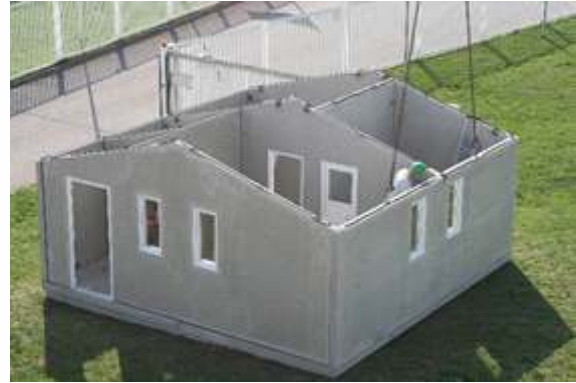
2. Instalación de los elementos de pared
