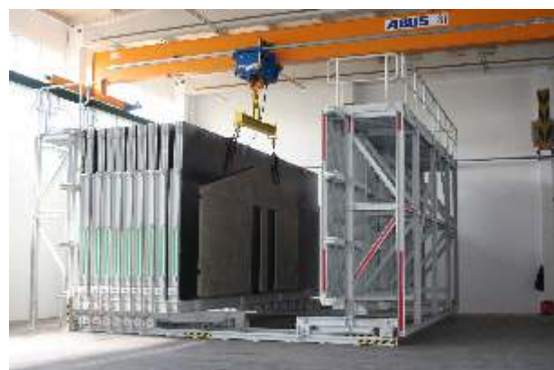
3. Retiro de la primera pared
